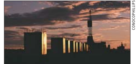
Kuparuk drill site
